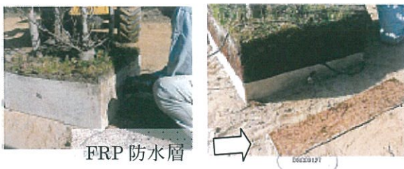
写真1 FRP防水層の一部を裁断採取
