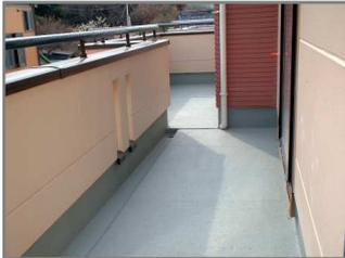
一般的な屋上防水の他、戸建住宅バルコニーなどにも多く採用されています。露出仕上げで防水層上の歩行が可能であるため、歩行用のベランダ、バルコニーなどに適用できます。
