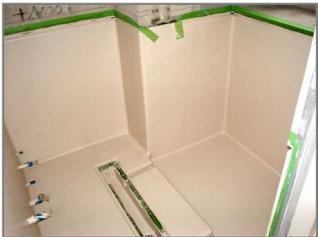
浴室は屋内での施工になるため、特に改修工事においては従来の FRP 防水に比べ臭気の少ない環境対応型 FRP 防水材料が採用されています。環境対応型 FRP 防水材料は、スチレンを全く使用しない樹脂やスチレンを低減している樹脂を用いる工法です。
