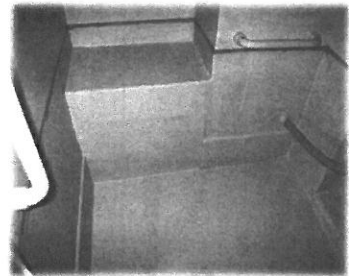
環境対応型FRP防水材料による 施工例(浴室の改修)
